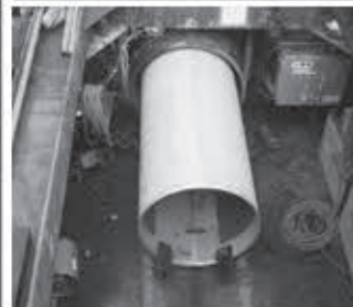
既設管1000mmに900Aを引込む
