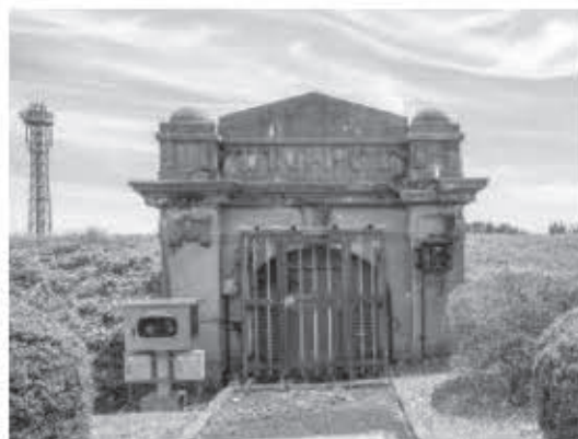
写真5 1号配水池坑門(移設前)
