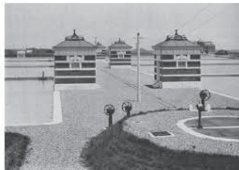
写真2 創建時のろ過池整水室上屋
