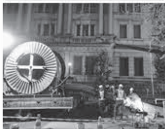
日本橋日銀通り 既設管800mmに400Aを引込む
