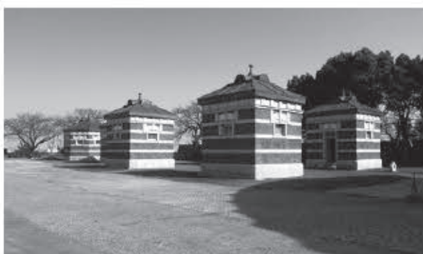
写真4 移設後の上屋
