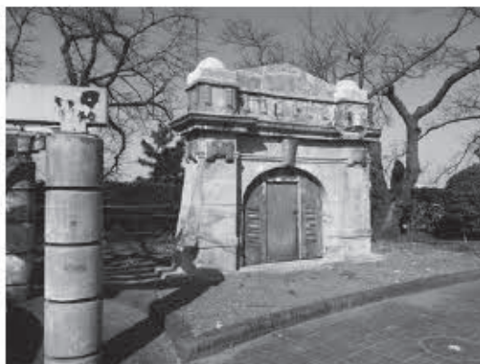
写真6 1号配水池坑門(移設後)
