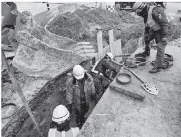
輪島市・応急復旧（提供：東京都水道局）
