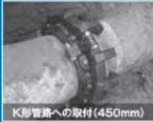
K形管路への取付(450mm)
