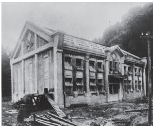
写真-2 水道創設当時の足羽揚水ポンプ場
