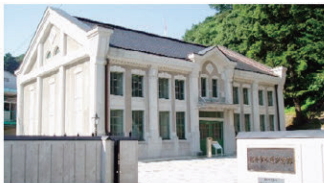
福井市水道記念館(旧足羽揚水ポンプ場)
