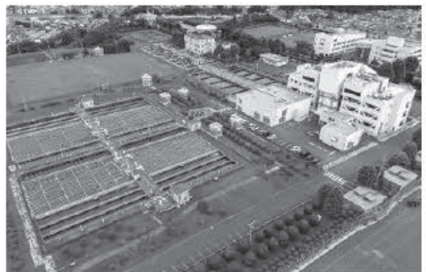
写真1 工事着手前の浄水場
